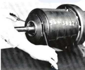
شکل ۱۳: خارج کردن پروانه
